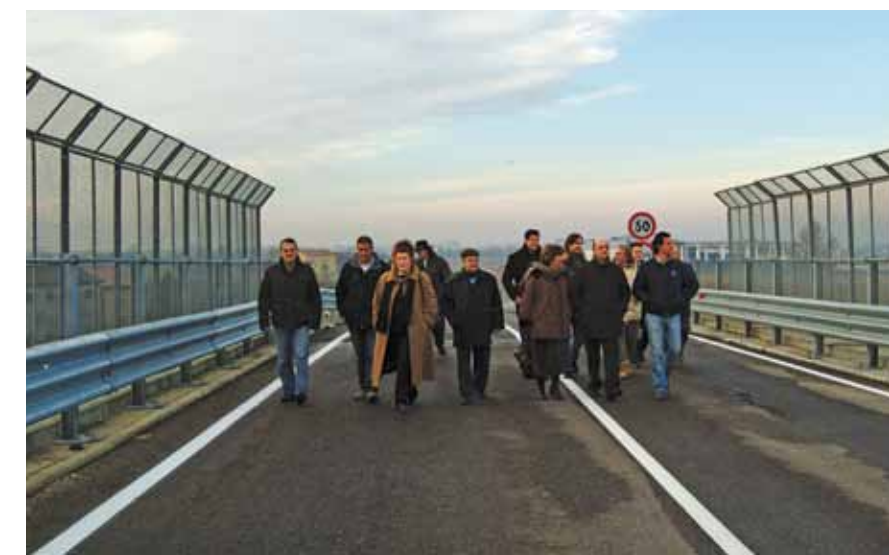
IL GIORNO DELL'APERTURA DEL CAVALCAVIA DIVIA MOTTA - In poco più di un anno l'amministrazione ha posto la parola fine all'odissea del sovrappasso della SS 434 procedendo alla sua bonifica e accelerando i tempi per la sua apertura. Oggi è un'arteria fondamentale per il traffico che da Cerea si dirige verso la Transpolesana e viceversa
