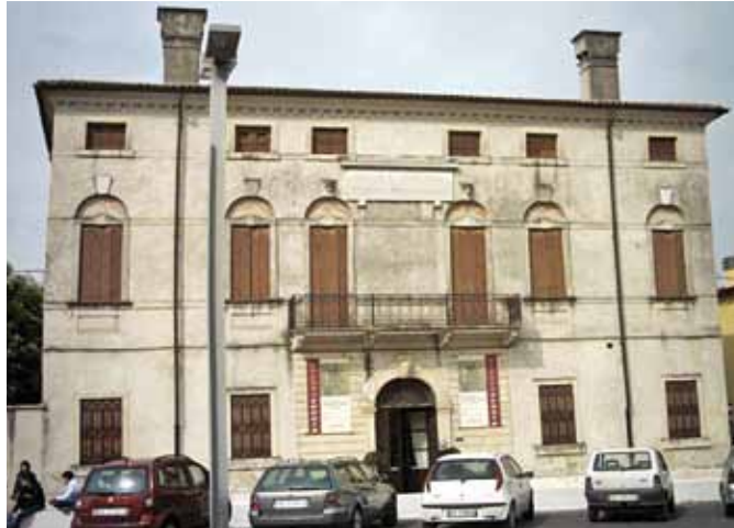
PALAZZO BRESCIANI - Al termine del restauro l'edificio storico ospiterà sei laboratori, un ufficio, due sale da destinare a riunioni, workshop ed attività dimostrative, un archivio, cinque locali da adibire a magazzino, due bagni, una piastra all'aperto e un salone d'entrata
